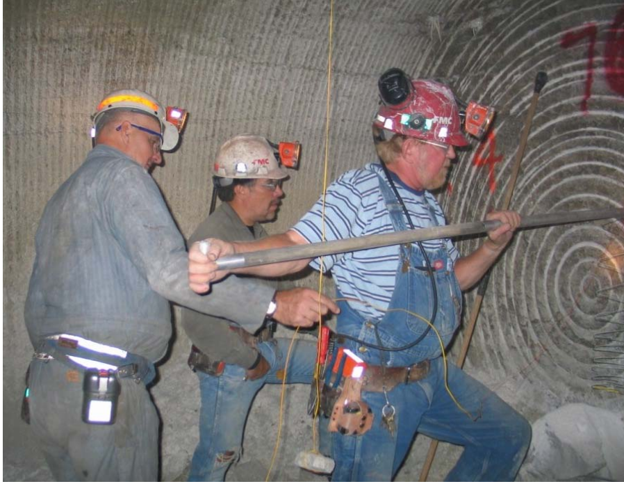
Stemming a blasting hole.
